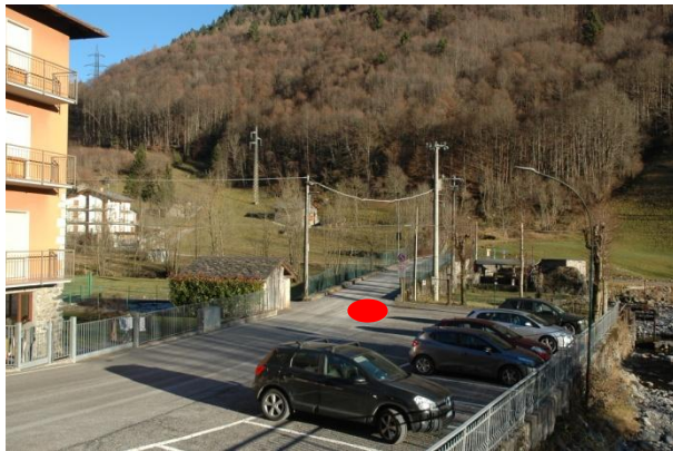
Ponte sul Fiume Serio a Fiumenero
