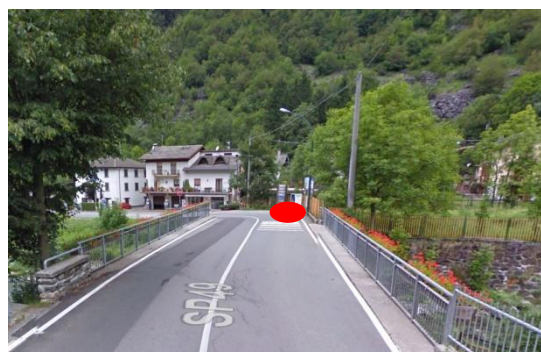
Ponte sul Fiume Serio all'ingresso di Valbondione
