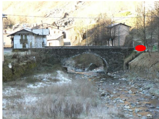
Ponte sul Fiume Serio in frazione Torre
