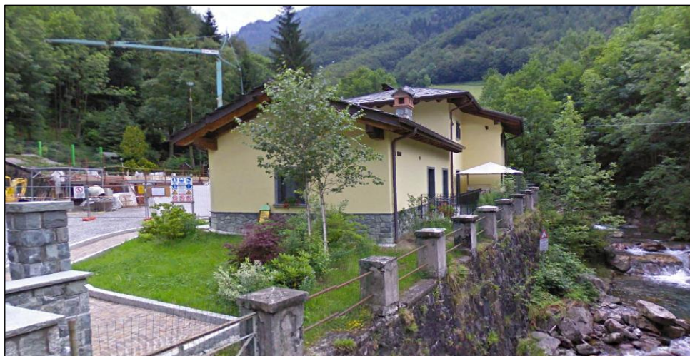
Vista della struttura dal ponticciolo di Via Pianlivere
