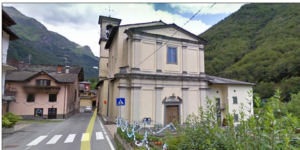
Chiesa di Fiumenero, Vista da S.P. 49
