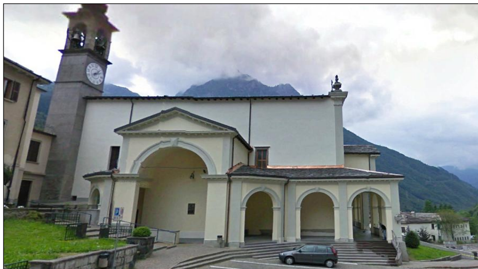
Chiesa di Valbondione, panoramica da S.P. n. 49 da nord
