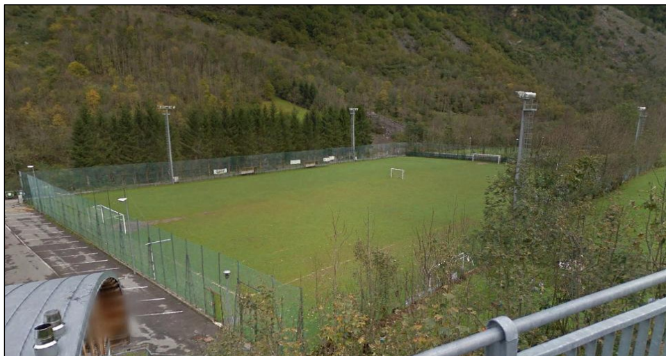
Panoramica del Campo sportivo
