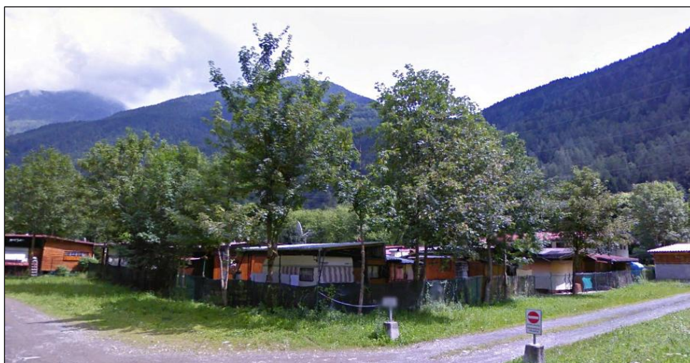
Vista di una porzione del campeggio (angolo ovest)
