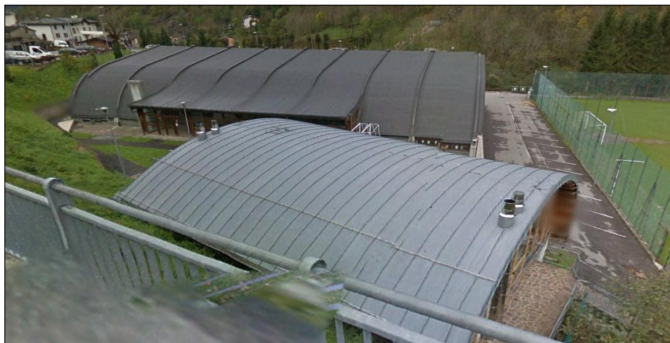
Vista panoramica del palazzetto dello sport
