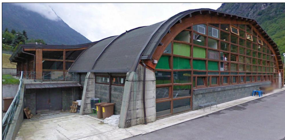
Vista frontale del palazzetto dello sport
