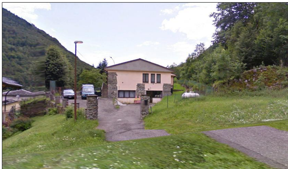
Vista accesso alla Casa Vacanze da Via Ponte
