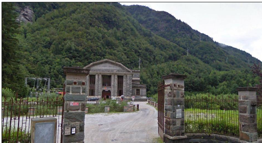
Figura 7 - Ingresso a impianto idroelettrico in località Dossi
